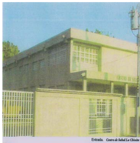
Fachada principal Centro de Salud
